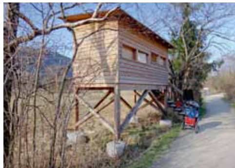
Abb. 9. Der neue Turm in der Weissenau. Die Rückseite Richtung NW gegen das Ried hin ist offen.
