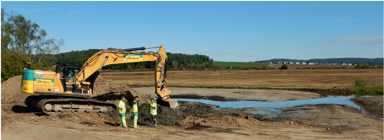
Neeracherried: Die letzten Bauarbeiten an der Renaturierung an der Westgrenze (siehe auch die Abbildung eingangs des Jahresberichts der Ala). Foto Werner Müller.
