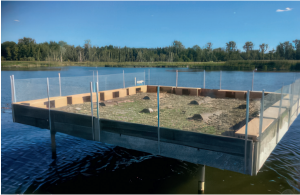
Die Brutplattform in der Fanellagune wurde nach den Hochwasserschäden des Vorjahres saniert. Foto 20. September 2022, Bruno Dubach.
