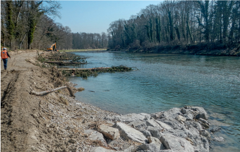
Abb. 15. Bau einer Holzbuhne. Diese bieten dem Eisvogel ideale Jagdplätze. Construction of a wooden groyne, offering ideal hunting grounds for the Kingfisher.
