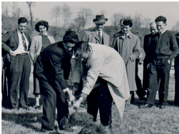
Abb. 6. Spatenstich für das Vogelwartegebäude am Ufer des Sempachersees, 28. März 1954, im Rahmen einer Beringertagung. Rechts Raymond Lévêque, links Luc Hoffmann mit seiner Frau Daria. Der Spatenstich wird von den beiden jüngsten Beringern Romano Bianchi und Michel Godel ausgeführt.
