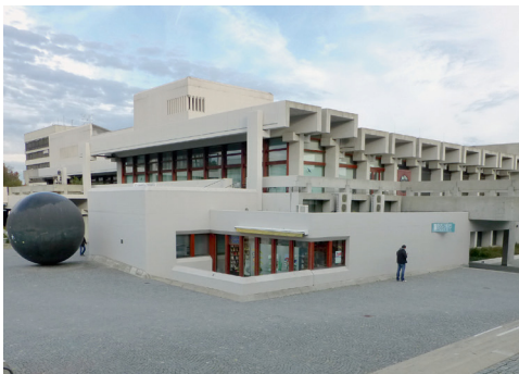
Abb. 2. Hörsaalgebäude der Universität Regensburg, von der Eingangstreppe der Universitätsbibliothek aus gesehen.
