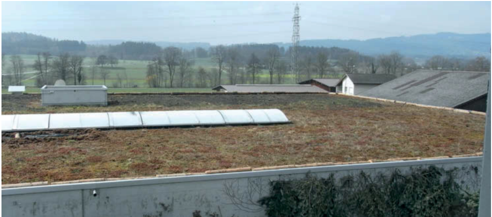
Abb. 2. Flachdach der Firma J. Meier Grüt Transporte AG in Gossau (Kanton Zürich). Aufnahme 22. März 2016, M. Villiger. – Flat roof of J. Meier Grüt Transporte AG in Gossau (canton of Zurich).
