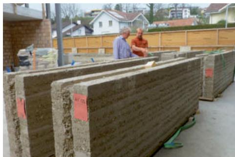
**Abb. 12.** Lehmbauer Martin Rauch (links) und ein Mitarbeiter besichtigen die ersten auf die Baustelle gelieferten Fassadenelemente. Die unregelmässige Schichtung der 45 cm dicken Elemente für die Fassade der Ausstellungshalle ist gut sichtbar. 4. April 2014.
