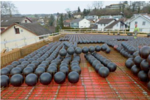
**Abb. 9.** Bionik am Bau: Fussballgrosse hohle Kunststoffkugeln werden in die Decke einbetoniert, um ihr Gewicht zu reduzieren. Sie ist damit «pneumatisiert» – wie die Schädeldecke von Vögeln. 10. Februar 2014. Alle Aufnahmen des Besuchszentrums C. Marti.
