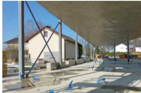
**Abb. 10.** Die geneigte Betondecke der Ausstellungshalle wird nur seitlich von Metallstützen getragen. Das Gebäudeskelett ist bereit zur Montage der Fassaden-Elemente aus Lehm. Dahinter der Vortragsaal des alten Vogelwartegebäudes von 1954/55. 12. März 2014.
