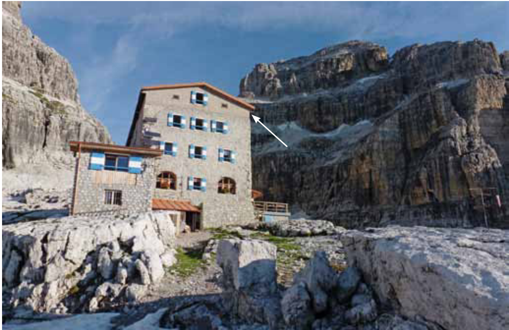
Abb. 1. Rifugio Tommaso Pedrotti in den Dolomiten. Der Brutort des Mauerläufers befand sich in der rechten Ecke des Gebäudes. Die Vögel landeten oft an der hier abgebildeten Ostfassade und kletterten zum Nistplatz hinauf. Der Haupteingang zur Hütte ist rechts über der Terrasse zu sehen. Aufnahme 25. Juli 2013, M. Gerber. – The stone building «Rifugio Tommaso Pedrotti» where a pair of Wall Creeper nested in 2013.
