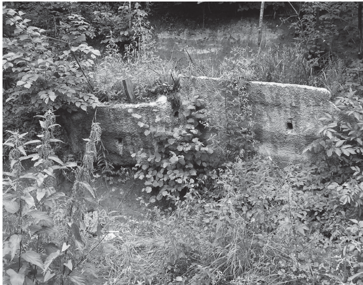
Abb. 3. Diese im Jahr 2004 erstellte Wand bietet Eisvögeln nur künstliche Niströhren an. Sie wurde bisher nicht benutzt. Mit Spritzbeton und beigemischten Farbstoffen ist die Wand allerdings hervorragend in die Umgebung eingepasst. Neubauten sollten im Gegensatz zu diesem Beispiel direkt am Wasser errichtet werden, um die Gefahr durch Prädatoren möglichst gering zu halten. Die linke künstliche Niströhre liegt zudem weniger als 90 cm über Grund und damit zu tief, um Prädatoren wirksam fernzuhalten. Aufnahme S. Wechsler. – This artificial nest site, built in 2004, offers artificial nest-holes only. No breeding was recorded so far. However, this wall matches the colours and structures of the surroundings excellently due to gunitite and added colours. Constructions should generally be built next to the water to keep the risk of predation as low as possible. The artificial nest-hole on the left is too low to keep predators away effectively.
