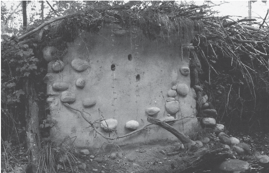
Abb. 4. Bei dieser Wand hat der Eisvogel trotz einer 12 cm dicken, betonierten Vorderwand durch drei Aussparungen die Möglichkeit, seine eigene Niströhre zu graben. Hinter der Betonvorderwand wurde deswegen eine spezielle Sand-Lehm-Mischung eingestampft. Der schräg aus dem Wasser ragende Ast unterhalb der Niströhre dient als Sitzwarte. Die überhängende Schicht aus Pflanzen und Ästen bildet eine Art Vordach und steigert die Attraktivität der Eisvogelwand zusätzlich. Diese Wand wurde bereits im ersten Jahr (2006) für drei Bruten benutzt. Aufnahme P. Teichert. – Three holes in the 12 cm outer concrete layer give access to a special sand-clay-mixture inside this nest site. A branch in the soil serves as a perch. The over-hanging layer of plant material and branches makes the artificial nest site more attractive to Kingfishers. This nest site was used for three consecutive broods already in the first breeding season (2006) after the construction.
