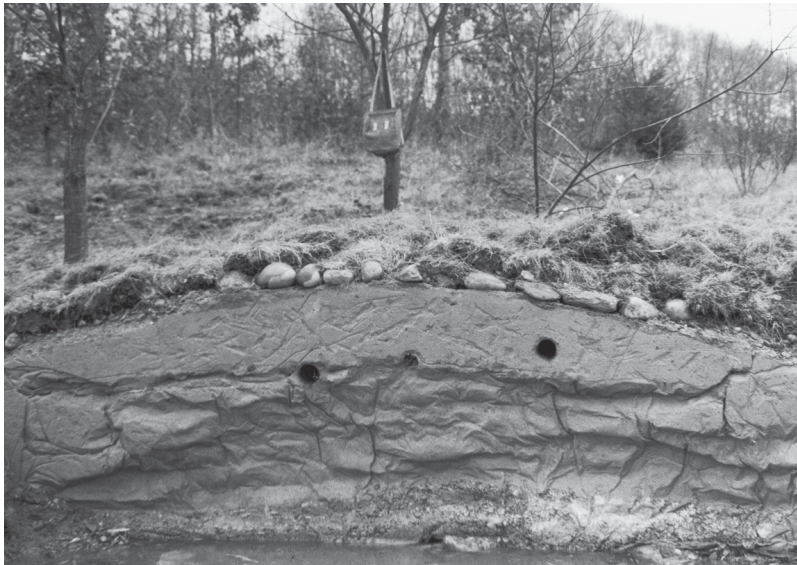
Abb. 6. Die vorderste Schicht dieser Brutwand wurde so stark mit Baukalk verhärtet, dass Eisvögel nicht hindurchgraben können. Drei Aussparungen ermöglichen es den Vögeln aber, sich dahinter selbst Niströhren zu graben. Ein zerknitterter Plastik zwischen Verschalung und Baumaterialien gab dieser Wand die natürlich wirkende Oberfläche. Sie wurde bislang noch nicht benutzt, möglicherweise weil eine natürliche Brutwand nur 700 m entfernt liegt. Aufnahme K. Schmid. – The outer layer of this artificial nest site was hardened with building lime to an extent that does not allow the Kingfisher to excavate a tunnel. But three holes through the first hard layer enable the Kingfisher to complete a tunnel behind. A crinkled plastic between boarding and building material gave this construction front its natural appearance. This site has not been used so far, maybe because a natural wall is situated only 700 m away.
