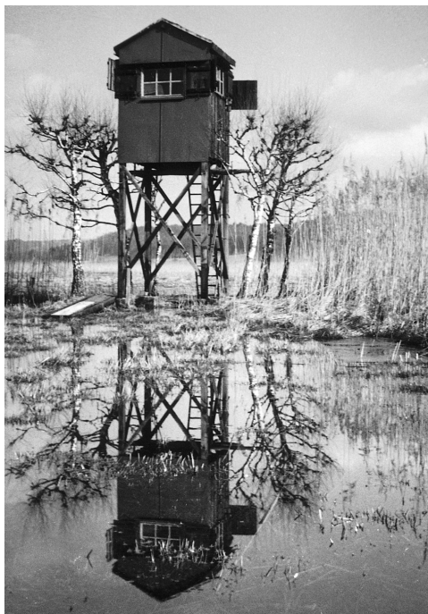
Abb. 2. Der Schinz-Turm im Neeracherried (hier im Zustand von 1927) wurde renoviert, wird aber nicht mehr benützt.
